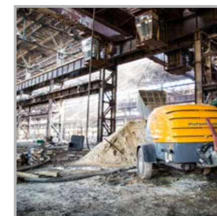
Russie, Ryazan coulée d'env. 100 000 m 2 de chape
