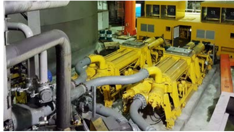
2台HSP泵将铁矿尾渣输送26.5km·Staryj Oskol·俄罗斯
