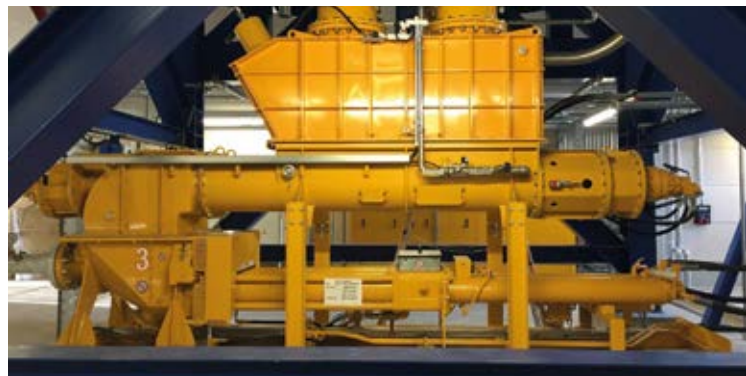
卡塞尔发电厂中的KOS柱塞泵配有THS和JT
