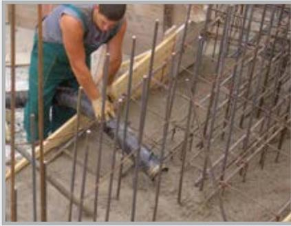
Las bombas de hormigón fino como la P 718 se caracterizan por ser unos de los sistemas más polivalentes. Pueden utilizarse para hormigón proyectado o para bombear hormigón fino de hasta 32 mm.
