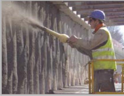
Feinbetonpumpen, wie die P 715, zählen zu den vielseitigsten Systemen. Sie können sie für Spritzbeton einsetzen oder für das Pumpen von Feinbeton bis 16 mm Korngröße.
