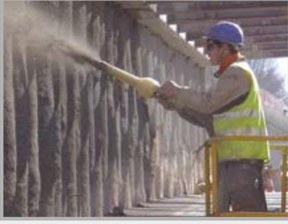
P 715 model ince beton pompaları gibi pompalar çok yönlü sistemlerdir. Bu pompalar ile enjeksiyon betonu veya tane boyutu azami 16 mm olan ince beton pompalanabilir.
