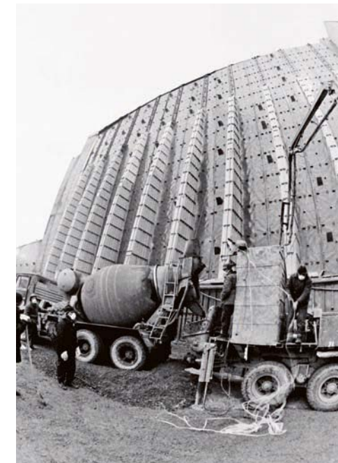
NOTEINSATZ NONSTOP Die Putzmeister-Pumpen liefen in den Monaten nach dem GAU rund um die Uhr.
