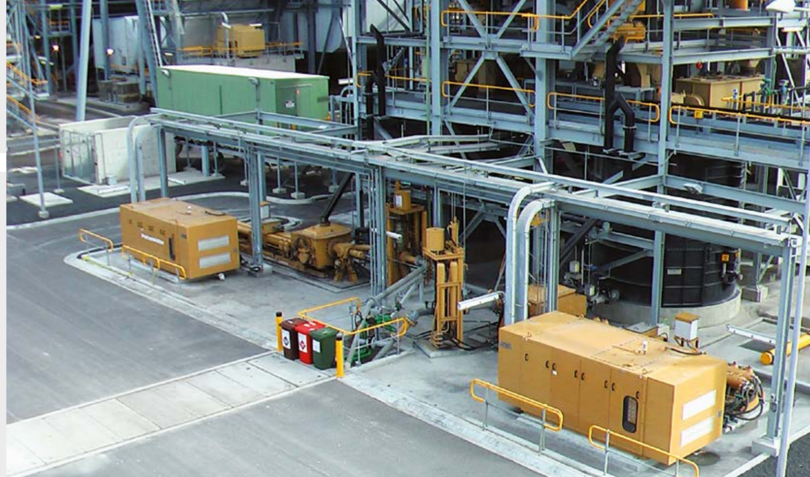
Redundanter Flug- und Bodenasetransport aus einem Kraftwerk
