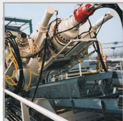
Schneckenförderer mit zwei Abraumpumpen Typ KOS 1480, Botlek Tunnel
