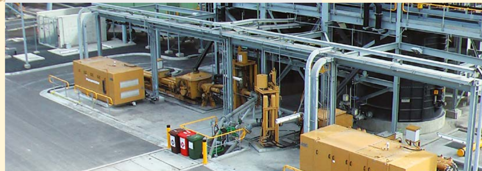
Flug- und Bodenasche Pumpstation KOS 25100 (Kogan Creek, Australien)
