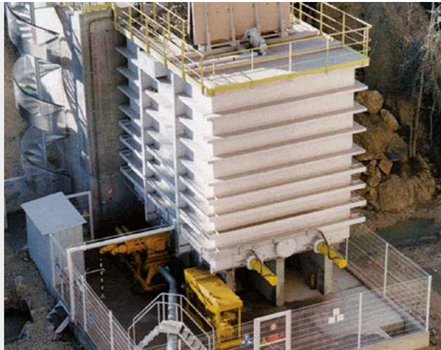
Mitverbrennung von alternativen Brennstoffen im Zementwerk Le Teil Lafarge, Frankreich
