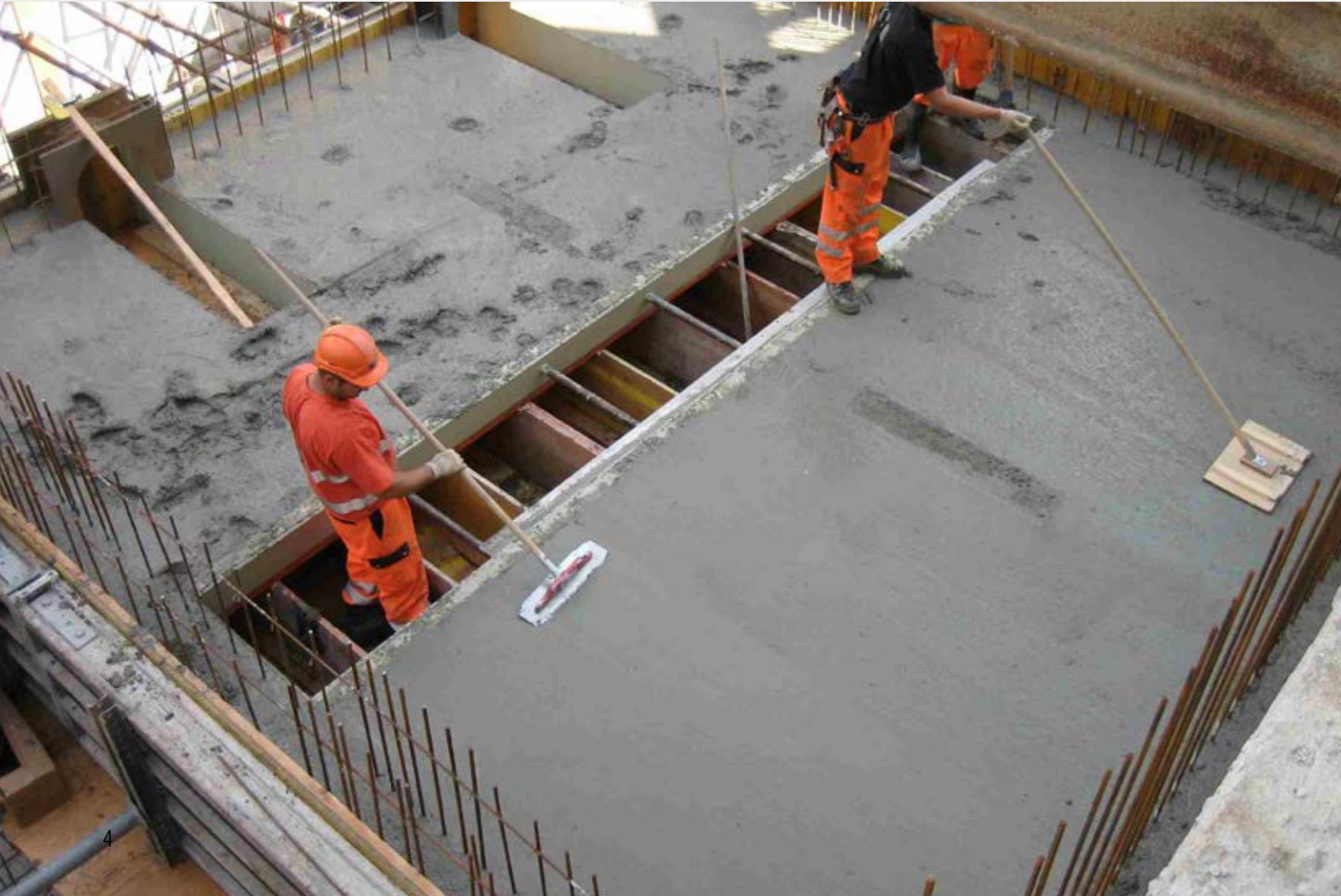
Beton bir karşılama sığnağının inşası
