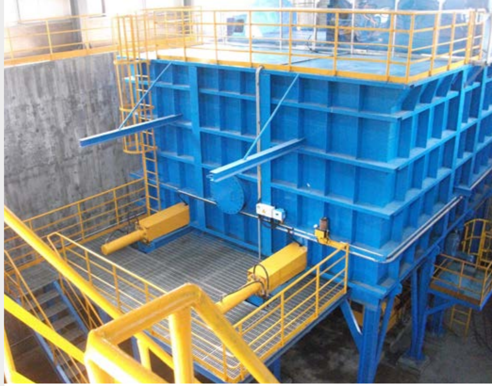
Yukarıdaki: Yer kazanımı ve kesin olarak kanıtlanmış : Sürücü silindireli silo tabanları içinde konumlanmıştır.
