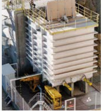
(Fransa) Le Teil Lafarge Çimento tesisindeki alternatif yakıtların yakılması
