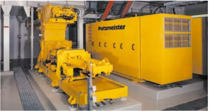
Kömür yakıtlı elektrik santrali Zolling (Almanya)' daki arıtma çamurunun yakılması: Katı pompa KOS 2180
