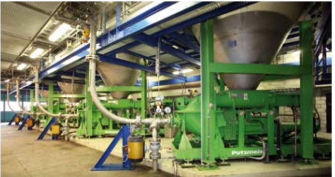
ProReno (Bazel, İsviçre) kanalizasyon işlerindeki katı pompa KOS 1050
