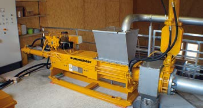
Donmuş gıda paketlerinin açmak ve nakletmek için (Avusturya) Kössen biyolojik mentanlaştırma tesisindeki EKO 1060 PP
