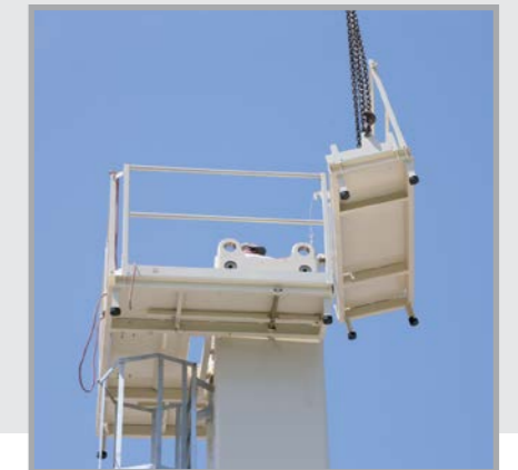
Aufbau eines MX-Mastes mit der optionalen Sicherheitsarbeitsbühne
