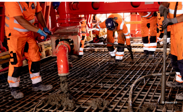
Gießen der Tunnelsohle mit Schwenkverteiler SV 7-3
