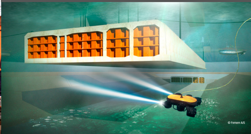
Absenken und Verbinden der Tunnelelemente
