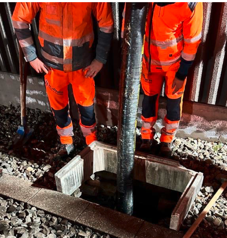
El hormigón autocompactante se introduce en la alcantarilla a través de un conducto estrecho
