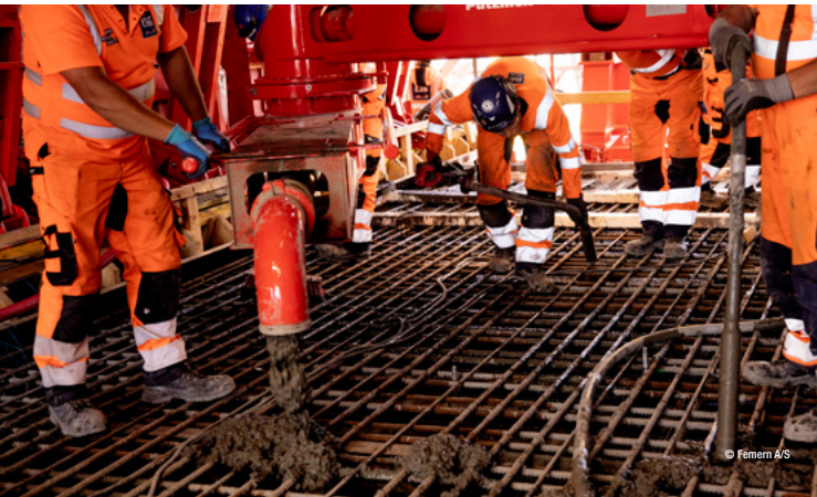
Tünel tabanının döner dağıtıcı SV 7-3 ile dökülmesi
