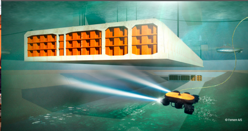
Tünel elemanlarının indirilmesi ve bağlanması
