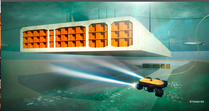
Descida e ligação dos elementos do túnel
