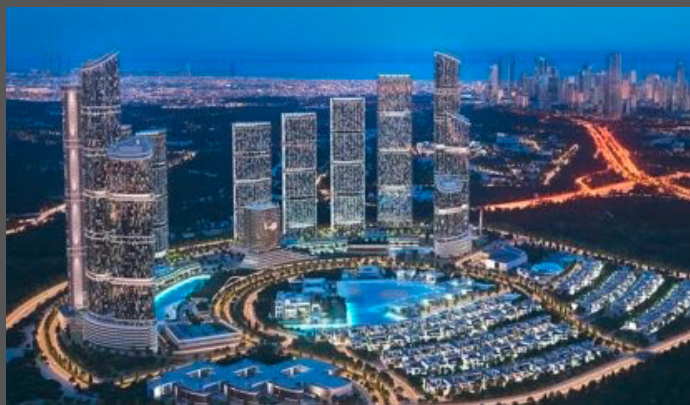
Fotografia do projeto após a conclusão
