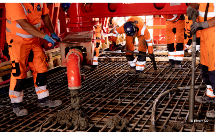
旋回打設機械 SV 7-3 を使用したトンネルインバートの施工
