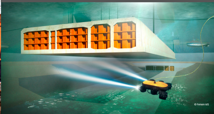
トンネルエレメントの沈設と接合
