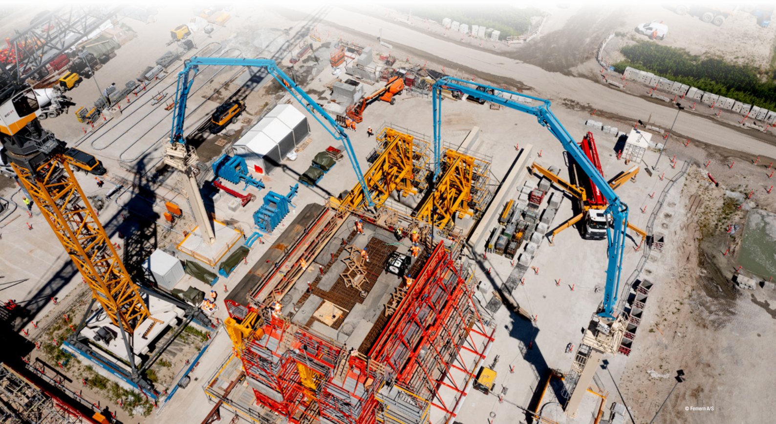
2基の定置式コンクリートポンプ BSA 2108 HP E と 2台の MXR 32-4 ブームを使用したトンネルセグメントのコンクリート打設
