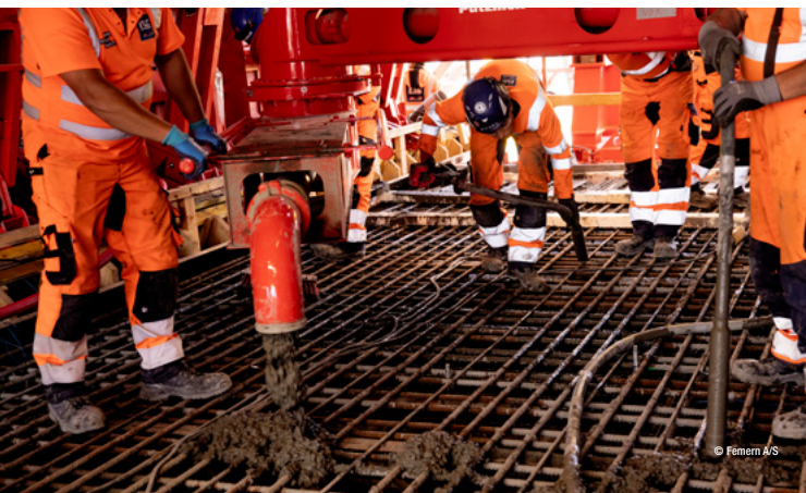
Coulage de la semelle du tunnel à l'aide d'un distributeur pivotant SV 7-3
