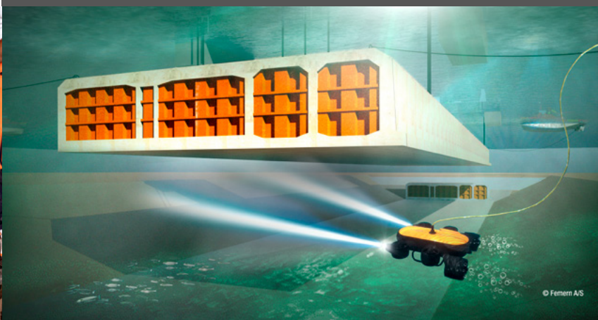
Descenso y conexión de los elementos del túnel
