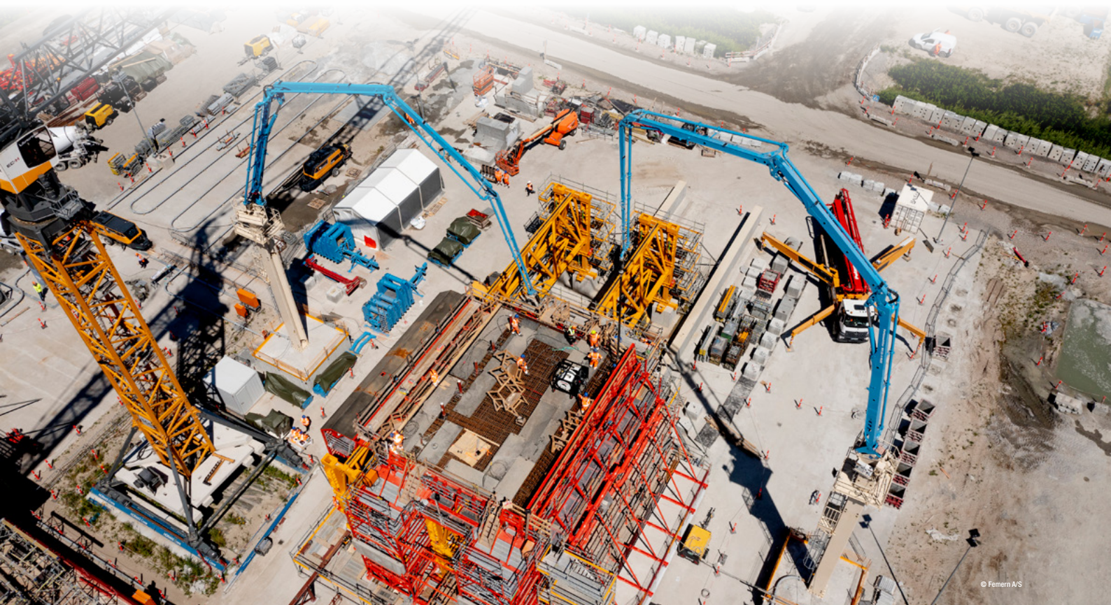
Hormigonado de un segmento del túnel con dos bombas de hormigón estacionarias BSA 2108 HP E y dos plumas distribuidoras MXR 32-4
