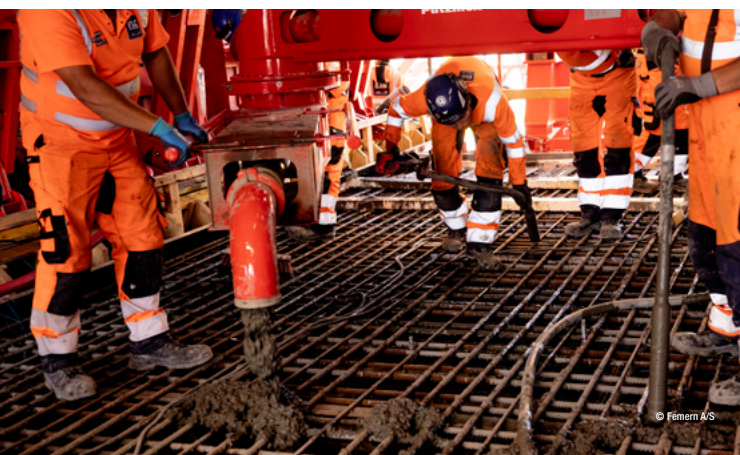
Vertido de la base del túnel con distribuidor giratorio SV 7-3
